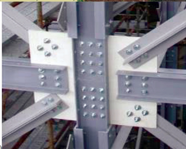
Рисунок 1 - а) Пешеходный мост около остановочного пункта Чертаново, б) Узловое соединение с применением стеклопластиковой фасонки [11]
