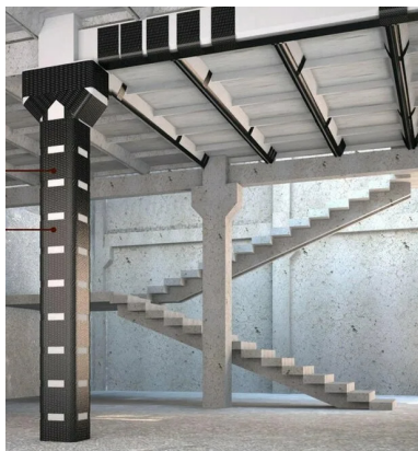
Рис. 1 - Усиление колонны композитными материалами.
